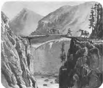
Brücke über den Den-dschu.
